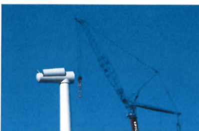
Installation de la nacelle
