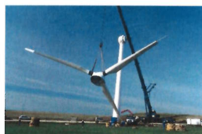
Mise en place du rotor tripale
