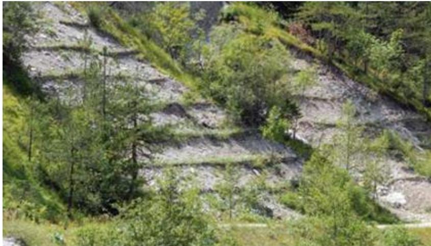
Fascinata Viva: la struttura è costituita da fascine con materiale vegetale vivo (astoni, verghe) fissate al terreno con picchetti spesso anch’essi in materiale vivo (talee). È idonea per pendii e scarpate naturali, e in ambito stradale e ferroviario. Talvolta è utilizzata a protezione di altre tipologie di ingegneria Naturalistica ( grata viva, palificata viva ).
