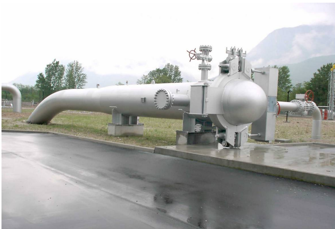
Foto 3.2/A: Punto di lancio e ricevimento pig
