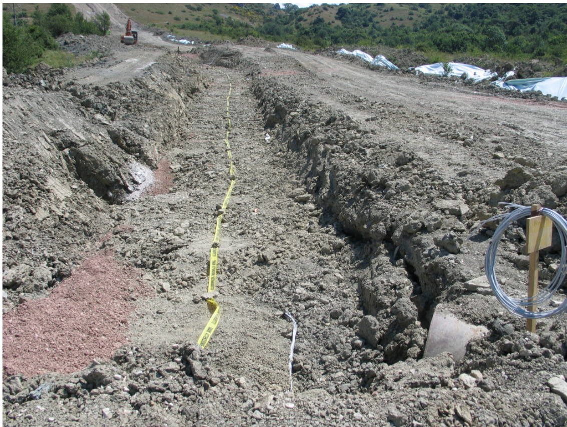
Foto 4.1/H: Rinterro della condotta
