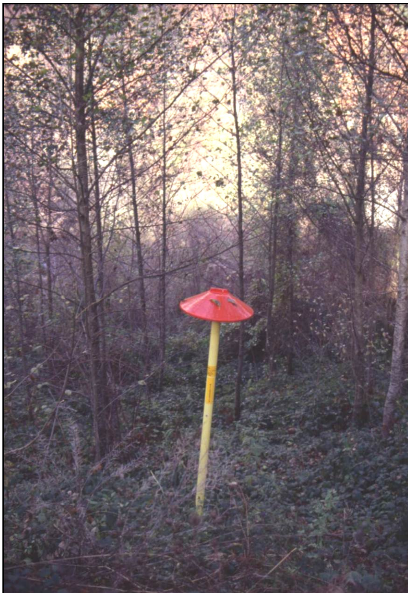
Foto 7/A: Metanodotto realizzato nel 1980 - rivegetazione naturale del tracciato del metanodotto (non sono stati eseguiti ripristini). Le paline sono totalmente nascoste dalla vegetazione.
