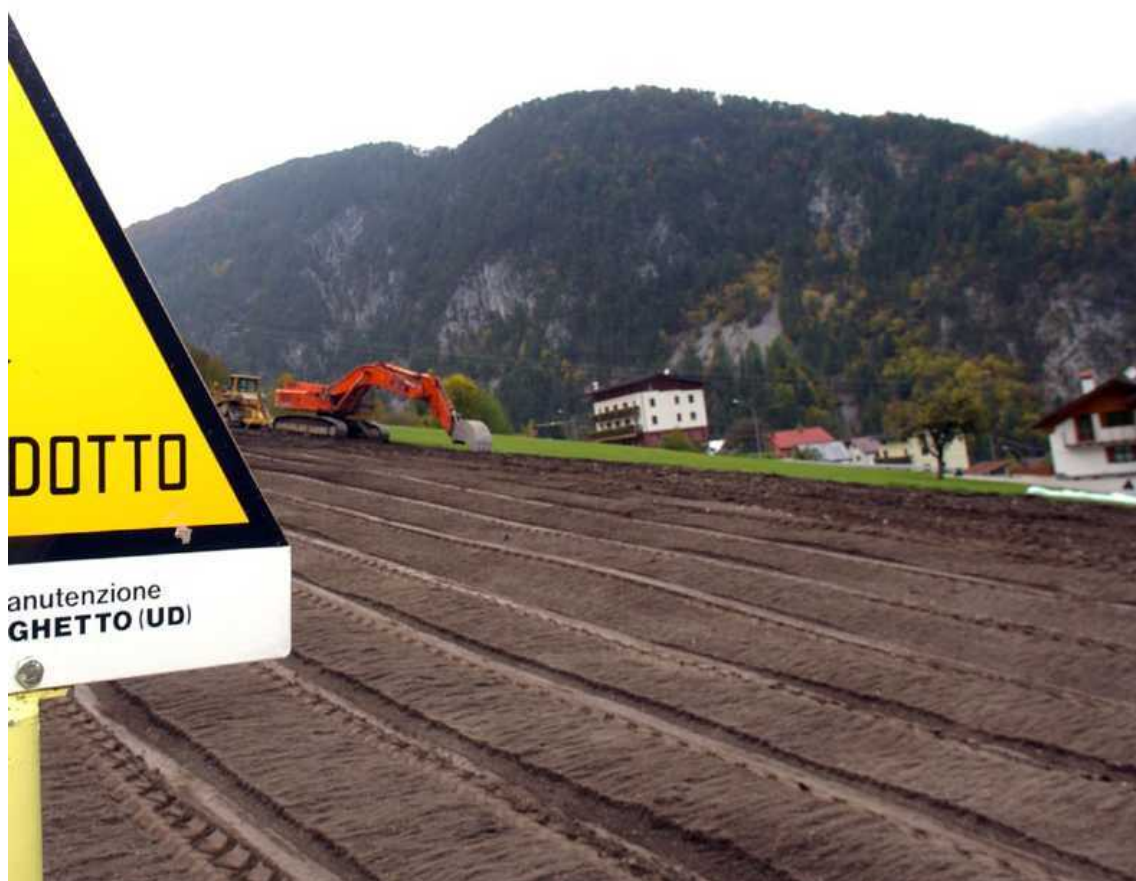
Foto 4.1/I: Ridistribuzione dello strato humico superficiale
