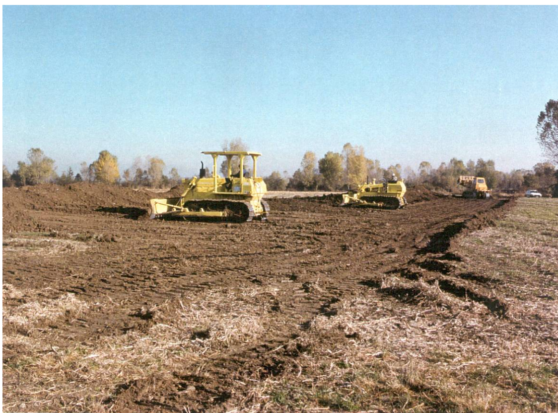
Foto 4.1/B: Apertura dell'area di passaggio
