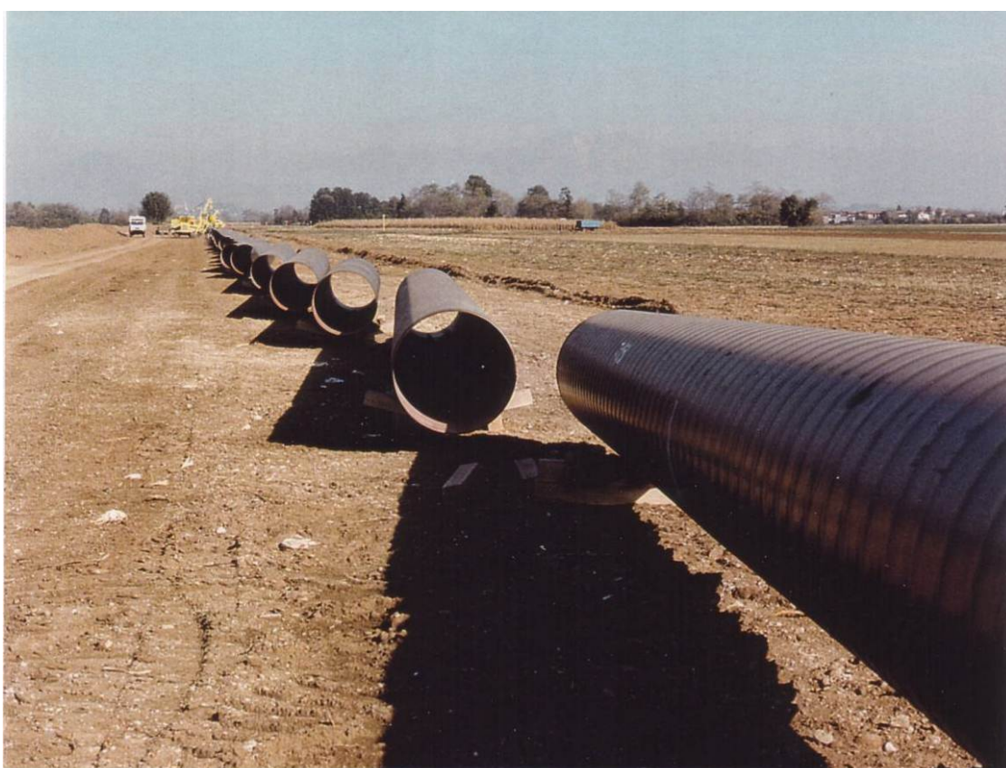
Foto 4.1/C: Sfilamento tubazioni
