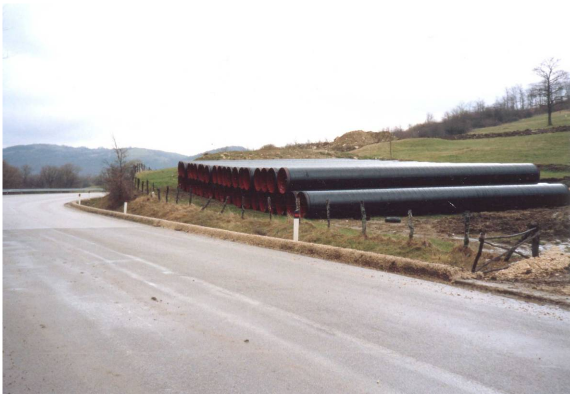
Foto 4.1/A: Piazzola di accatastamento tubazioni
