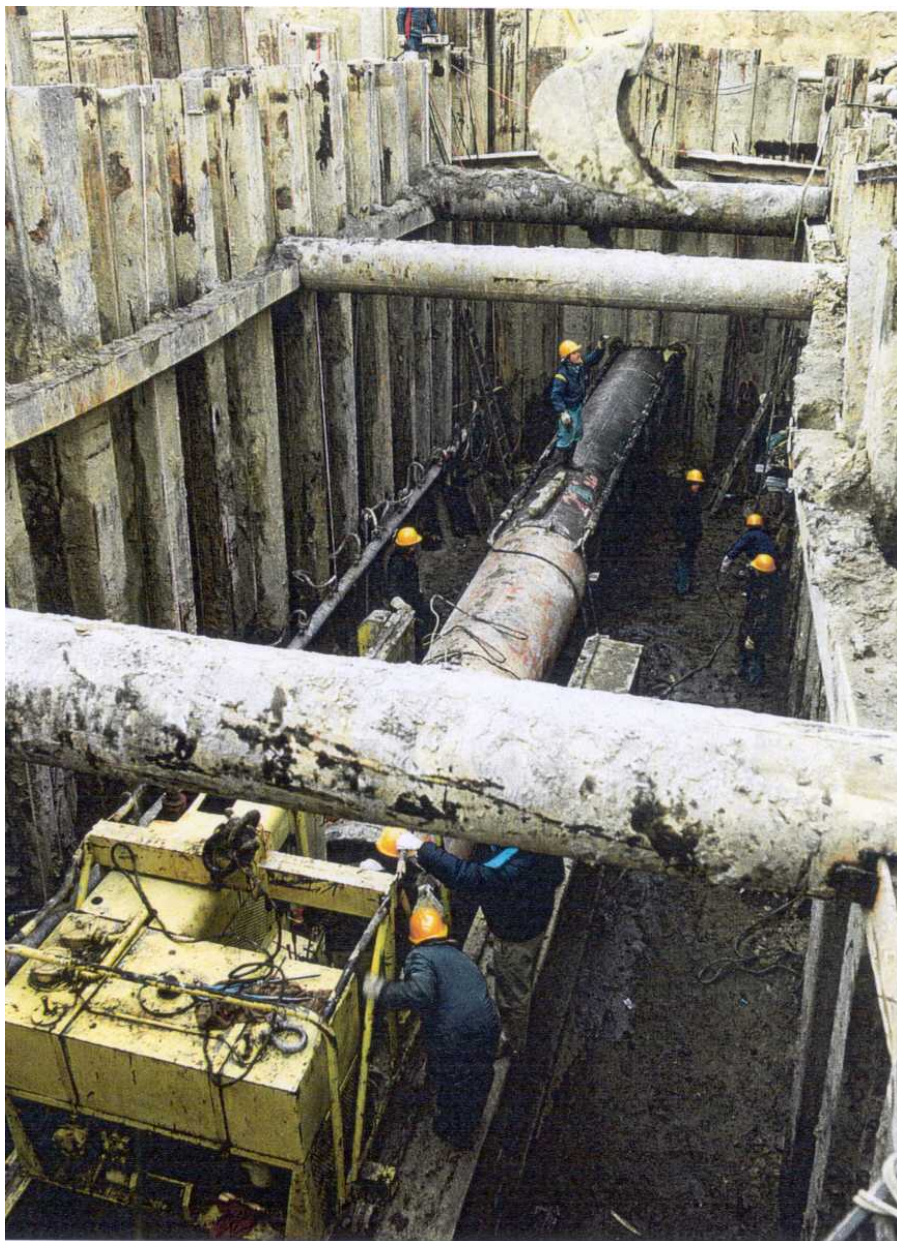
Foto 4.1/L: Trivellazione con spingitubo
