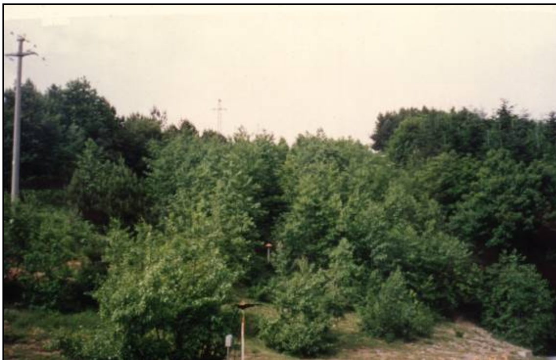
Foto 7/B: Metanodotto realizzato nel 1985 - la vegetazione naturale (non sono stati eseguiti ripristini) sta ricoprendo la pista di lavoro del metanodotto.
