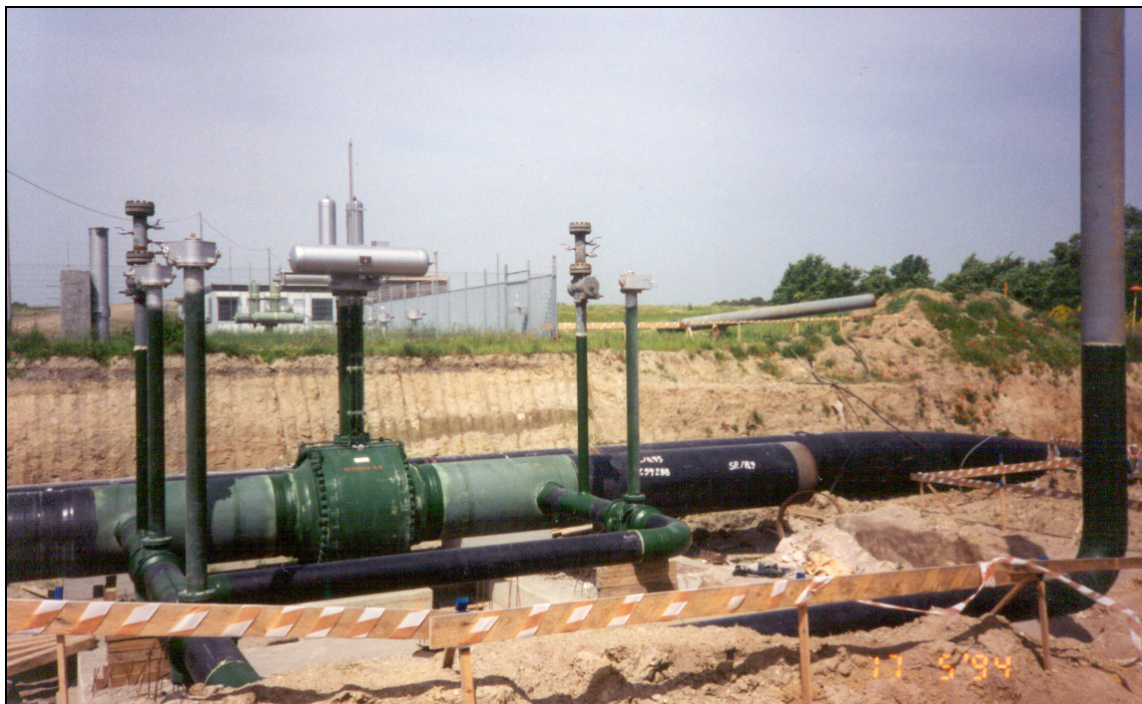
Foto 4.1/N: Punto di intercettazione di linea (PIL)
