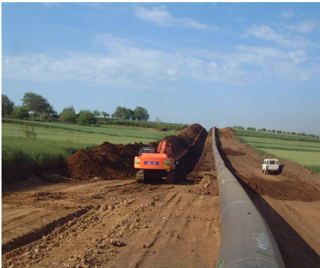
Foto 4.1/E: Scavo della trincea
