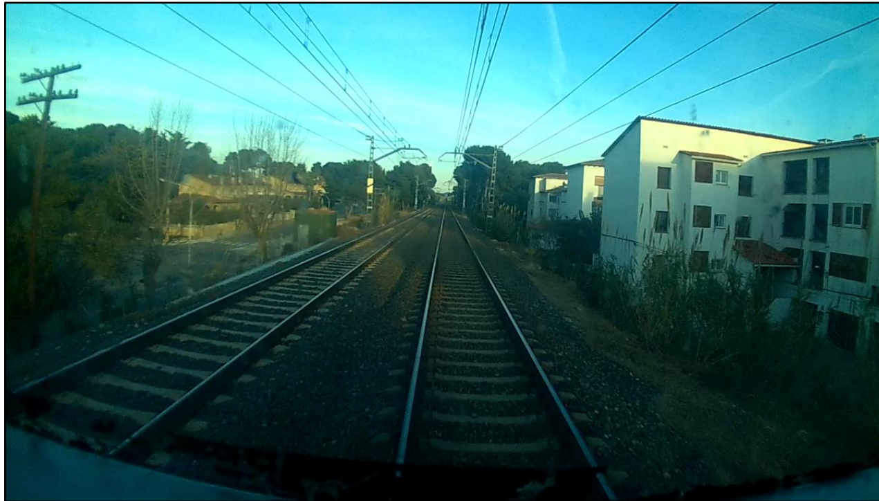
Foto de edificaciones próximas al eje. Proximidades Torredembarra.
