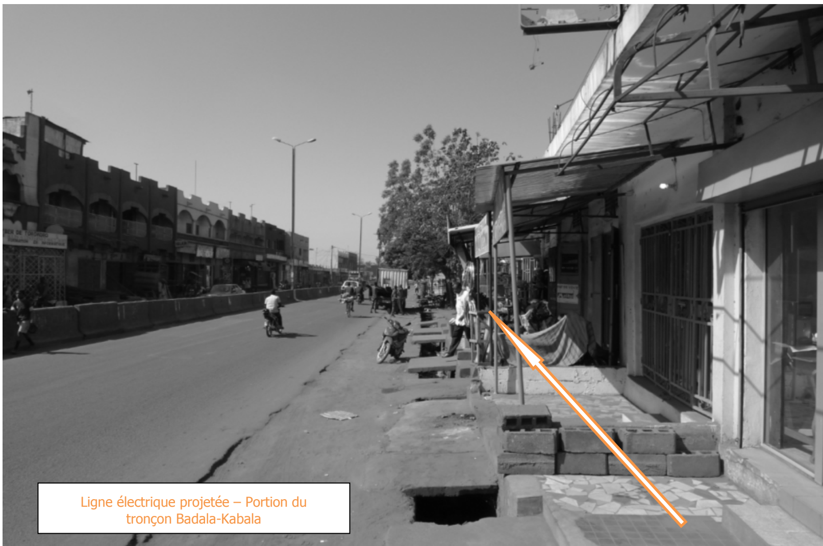
LIGNE ELECTRIQUE PROJETEE – PORTION DU TRONÇON BADALA-KABALA
