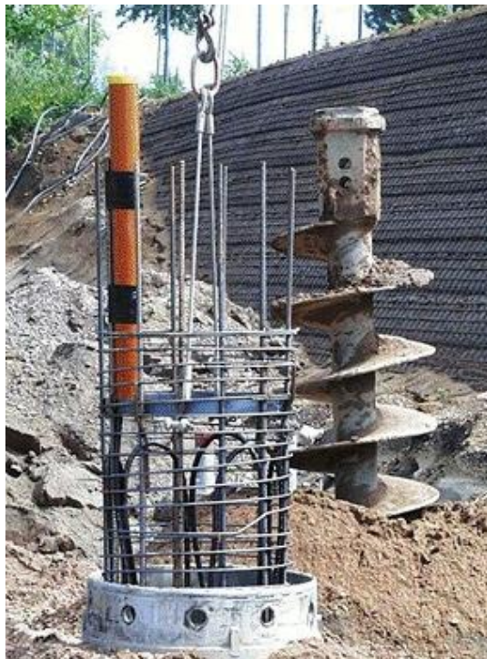
Photos: pieux énergétiques (activation thermique des pieux de fondation)
