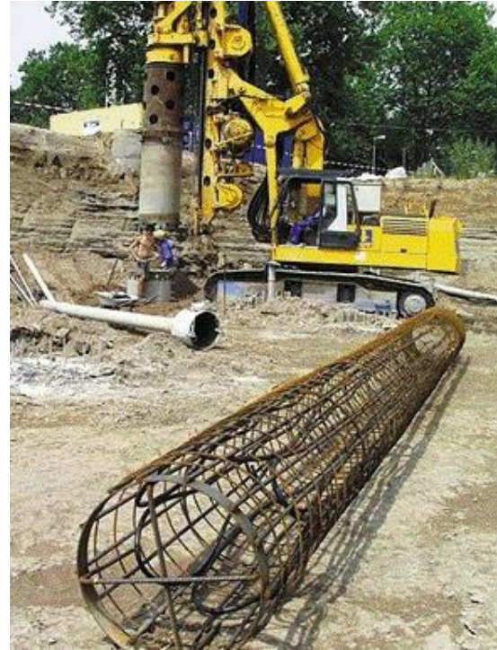
Photos: pieux énergétiques (activation thermique des pieux de fondation)
