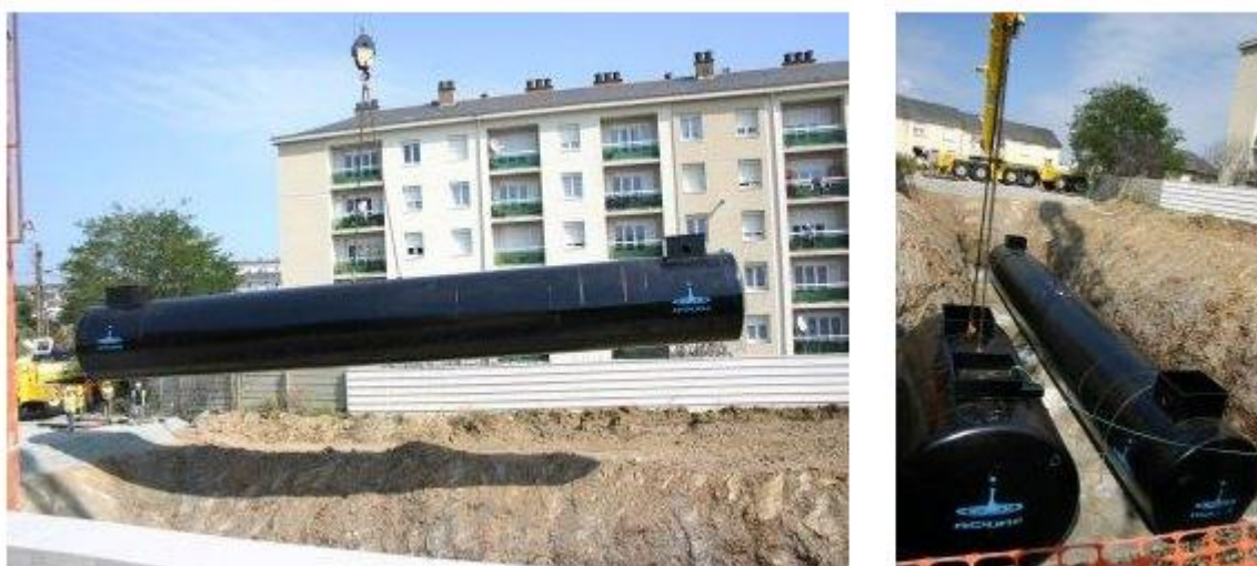
Figure 49 - Citerne acier avec filtration intégrée AQUAE
