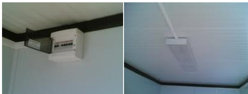
Imagen 21. Cuadro general de protección.
