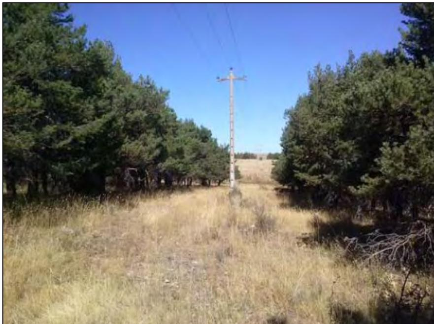
*Tramo de línea existente a desmontar (CTO CSP707), ubicado sobre zona forestal arbolada. La nueva línea evita esta zona proyectándose, entre los vértices "4" a "9", sobre el camino rural existente que transcurre paralelo a la vía de ferrocarril. Se evitan así talas innecesarias.*
