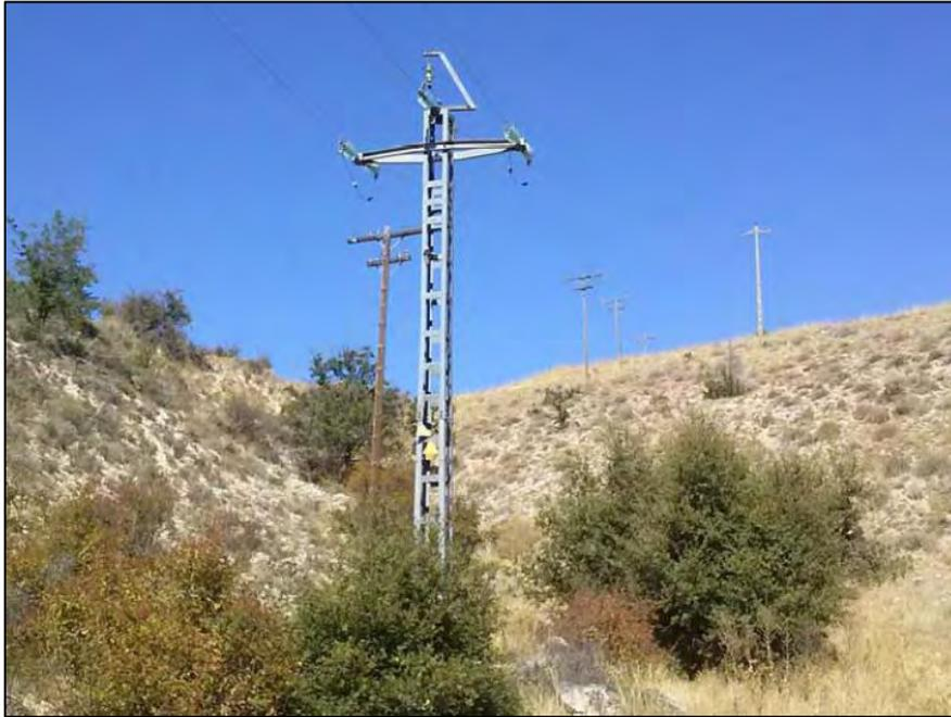
*Apoyo existente (CTO CSP707) con aislador rígido por encima de la cruceta, de alta peligrosidad para la avifauna. La reforma de línea proyectada permitirá el desmantelamiento de este tipo de apoyos adaptando la línea aérea existente a las prescripciones técnicas establecidas en materia de protección de la avifauna.*
