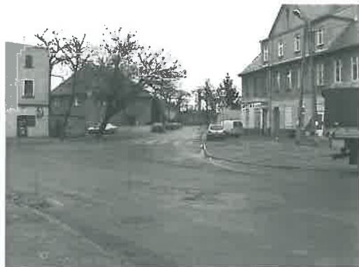
Fotografia 4. Wlot ul. Zatorskiej od ul. Okulickiego
