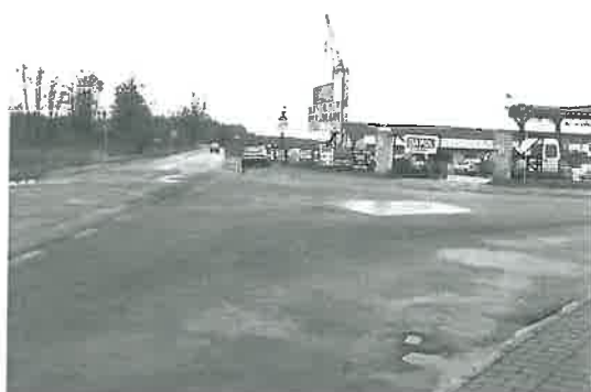
Fotografia 21. Skrzyżowanie ul. Odolanowskiej z ul. Okulickiego, widok w kierunku granicy miasta, widoczne magazyny materiałów budowlanych
