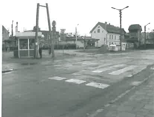
Fotografia 8. Istniejąca pętla autobusowa; kiosk, w głębi sklepy i stacja transformatorowa
