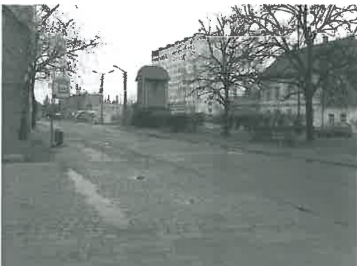
Fotografia 6. Skwer między ul. Księżycowa a ul. Okulickiego, po prawej stronie stacja transformatorowa
