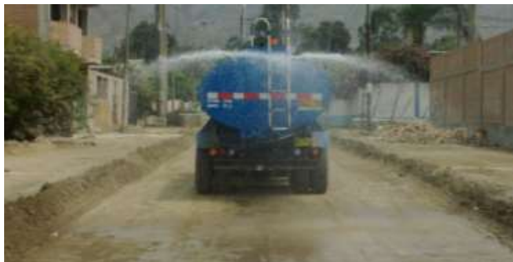
Figura 14.2. Ejemplo de humedecimiento con camión cisterna
