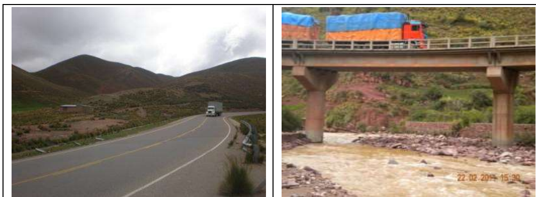
Foto 3.1: Carretera Oruro – Cochabamba
