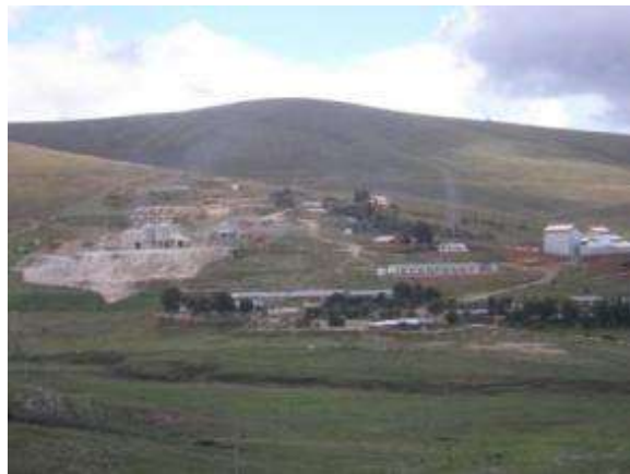
Foto 5.64: Calera Sayari S.A. (Municipio Tapacarí), Tramo 2
