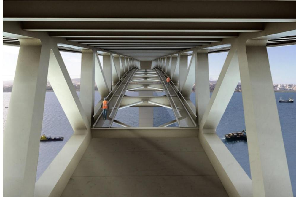
Image à l'intérieur du treillis, avec les passerelles d'entretien.
