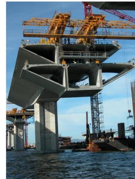
Exemple de construction de tablier : Pont d'East Bay San Francisco, Californie, États-Unis avec voiles latérales minces, levage de pièces préfabriquées
