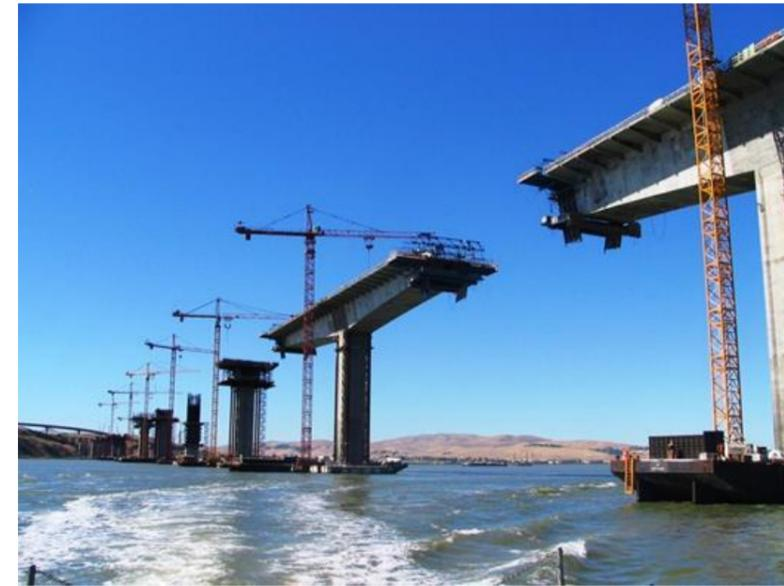
Exemple de construction de tablier : Pont de Benicia– Martinez, Californie, États-Unis, avec nervuré précontraint, bétonnage sur site.
