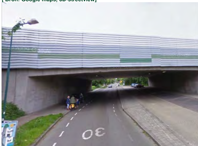
Afbeelding 47 Onderdoorgang KW02 tunnel Groenekanseweg (Ruigenhoek) [ Bron: Google maps, 3D-streetview ]
