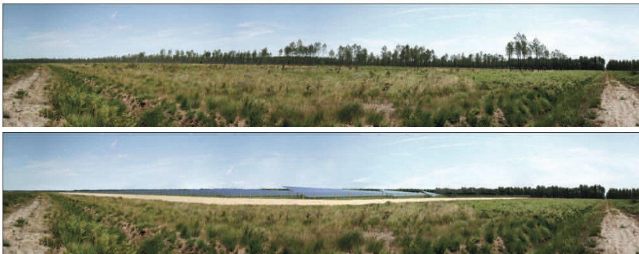
Illustration 1 : Depuis le sud-ouest, vue avant/après sur la centrale photovoltaïque du Toret.
