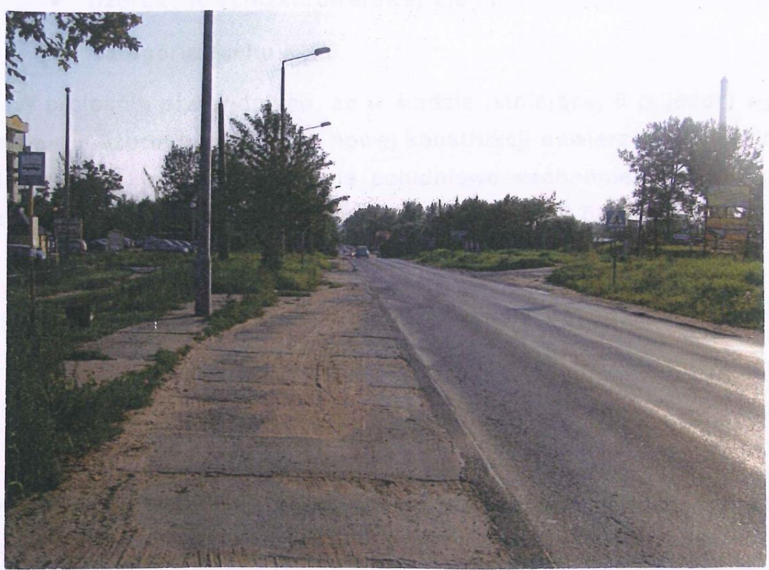
Fot. 2 przepust Strugi Toruńskiej w profilu obecnej ul.Olsztyńskiej
