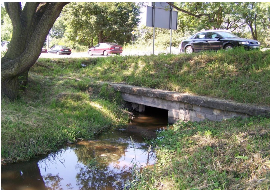
Fot. 3 ul.Olsztyńska – pas pod drugą jezdnią (widok w kierunku przejazdu kolejowego)
