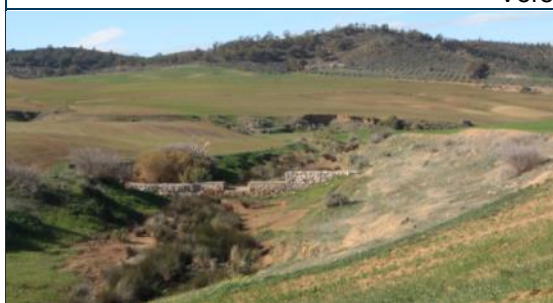
Oued stabilisé par des gabions
