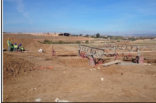
ورشة وضع أبراج الطاقة الكهربائية، الخط 225 كيلوفولط بير مشرق - بوفيشة
