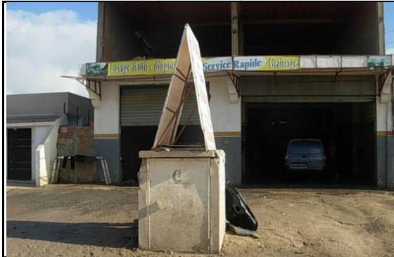
"كوة" المراقبة للكوابل تحت الأرضية
