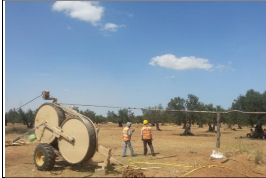
تمرير الكوابل، خط مساكن - سوسة (المصدر STEG)
