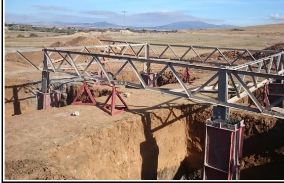
ورشة وضع أبراج الطاقة الكهربائية، الخط 225 كيلوفولط بير مشرق - بوفيشة
