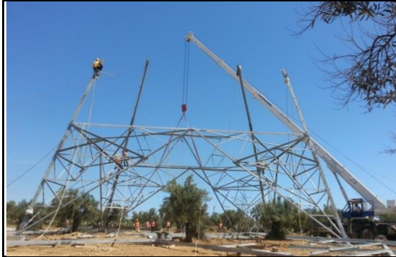
ورشة وضع أبراج الطاقة الكهربائية، الخط 400 كيلوفولط مساكن - سوسة (المصدر STEG)
