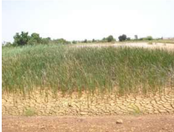
Figure 12 : Plantes aquatiques présentes dans une des lagunes à boues de la station de traitement existante
