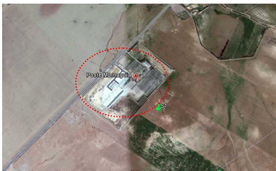
Figure 4 : Extension du poste de Mornaguia
