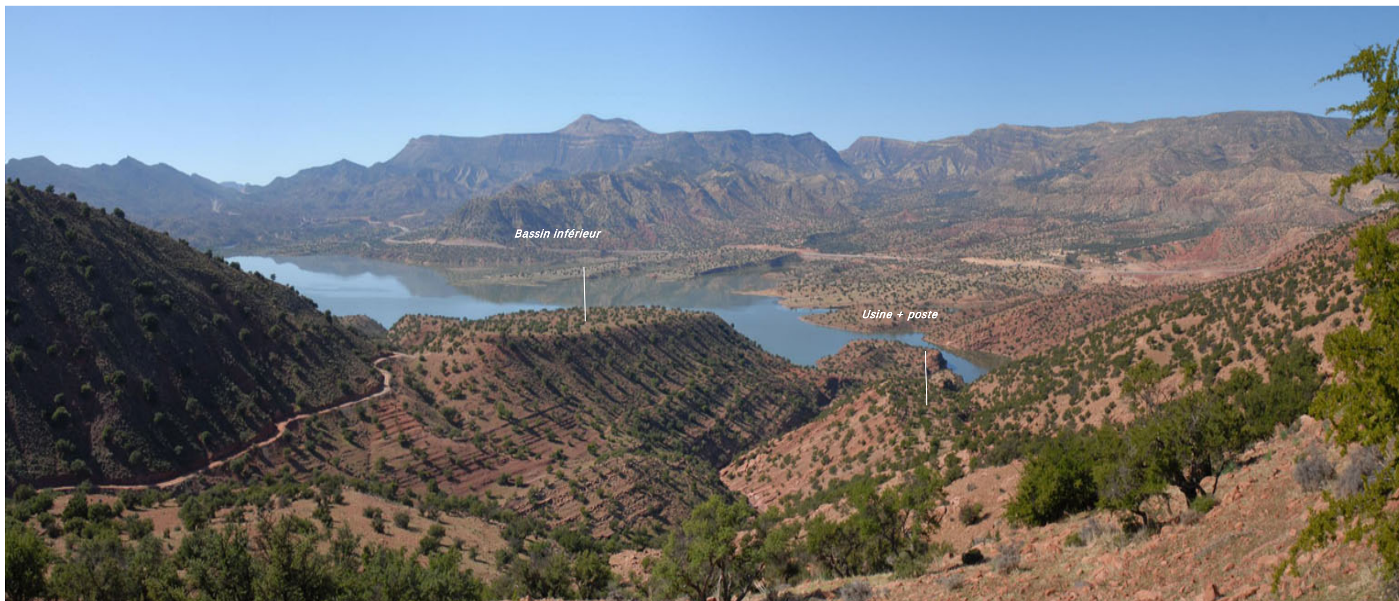
Figure 55 : Vue sur les terrains qui accueilleront les éléments inférieurs du projet : bassin inférieur, usine et poste
