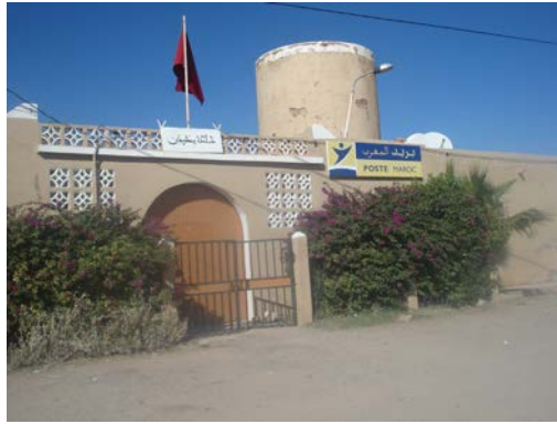
Figure 42 : Bureau de poste de la commune de Bigoudine
