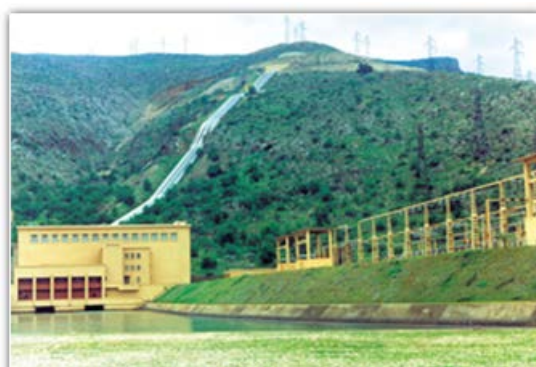
Figure 7 : Conduite reliant le bassin supérieur et inférieur de la STEP d'Afourer 10
