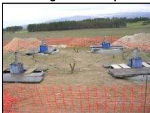
Vista após Betonagem
