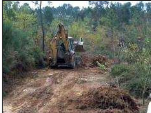
Trabalhos de desmatamento
