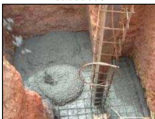
Betonagem do cabouco
