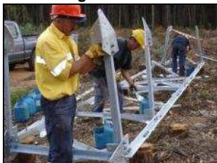
Montagem de um apoio
