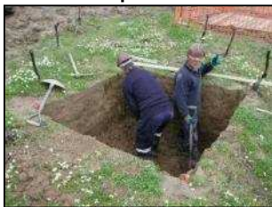
Trabalhos de escavação dos caboucos
