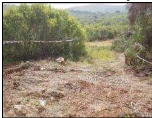
Trabalhos de sinalização dos apoios
