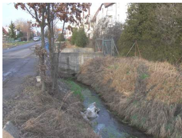
Fotografia 11. Rów melioracyjny przed posesją nr 68
