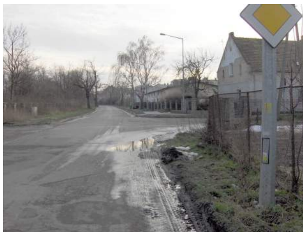
Fotografia 16. Wylot z Wrocławia, zabudowa mieszkaniowa niska
