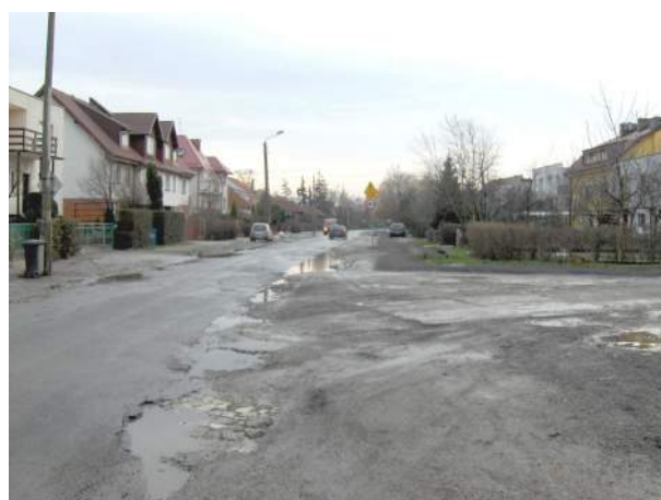
Fotografia 5. Ul. Kutrzeby od ul. Abrahama
