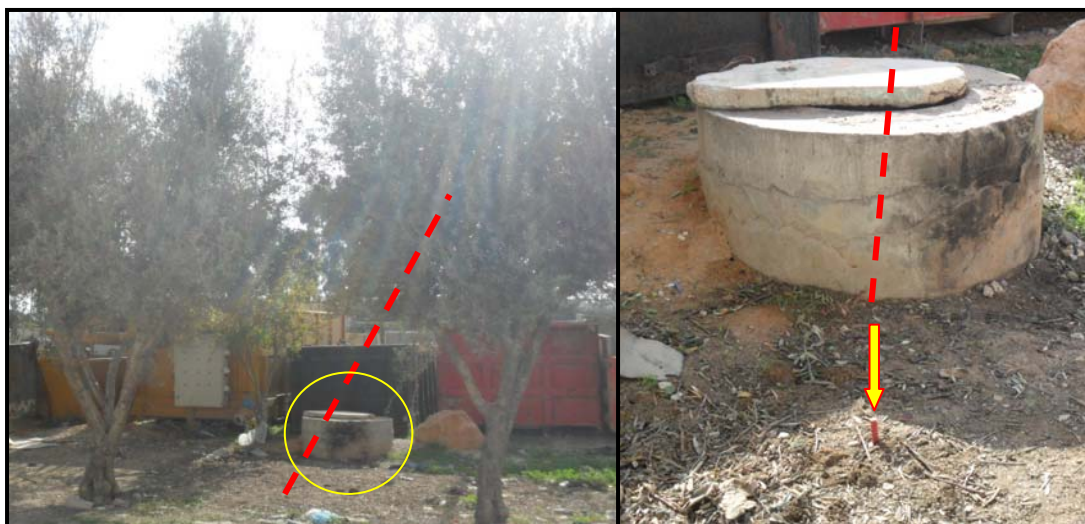
Fig. 12: Réseau d'assainissement (ONAS) dans le site d'implantation du viaduc (extrémité Est).
