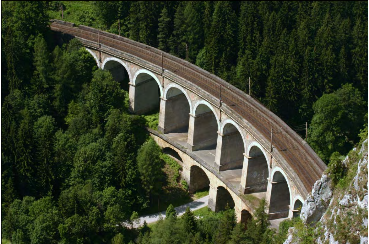
Abbildung 7: Viadukt über die Kalte Rinne der Semmeringbahn (Foto: © Erich Kodym)
