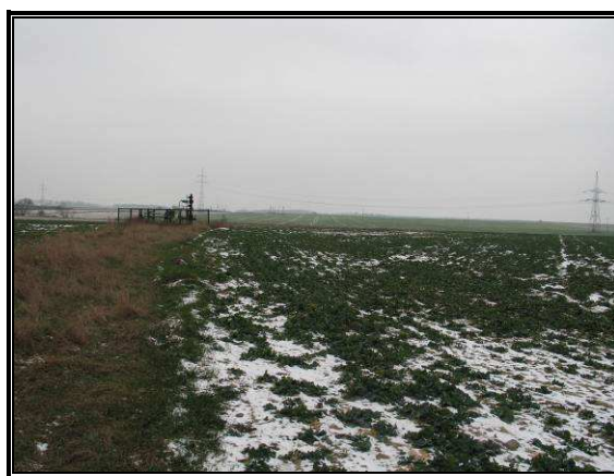
Fot. 3.14 Stacja redukcyjna gazu oraz przebieg drogi ekspresowej w kierunku południowym
