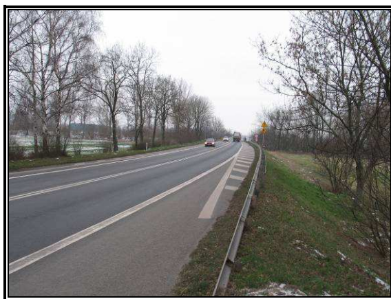
Fot. 3.27 W tle obiekt mostowy nad kanałem Mosińskim
