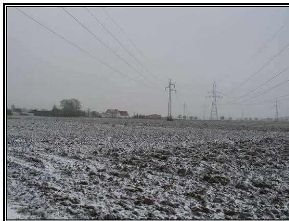
Fot. 3.2 Linia energetyczna 110 kV i 220 kV
