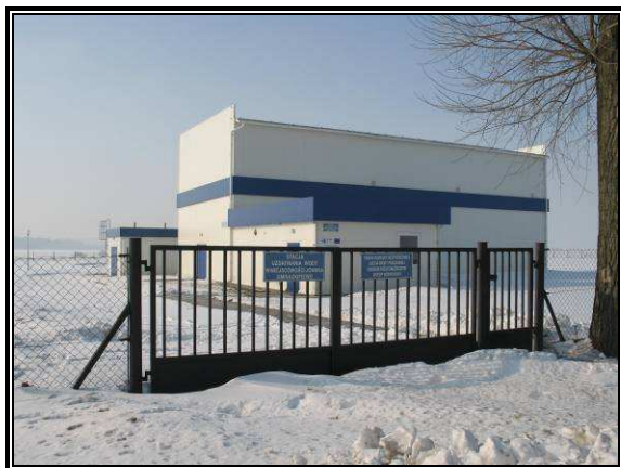
Fot. 3.7 Stacja uzdatniania wody oraz teren strefy ochrony bezpośredniej ujęcia.
