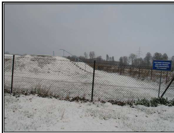
Fot. 3.45 Strefa ochrony bezpośredniej ujęcia wody
