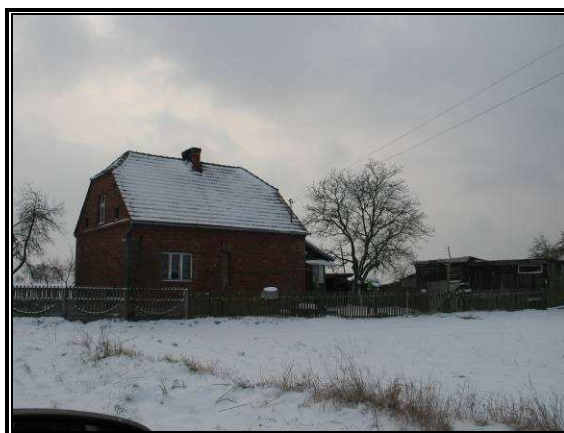
Fot. 3.47 Budynek mieszkalny we wsi Smyczyna przewidziany do wyburzenia
