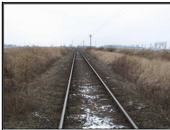
Fot. 3.17 Linia kolejowa nr 357
