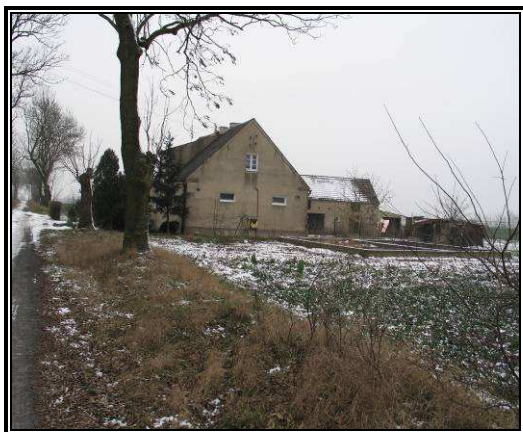
Fot. 3.29 Położony w bezpośrednim sąsiedztwie pasa drogowego
