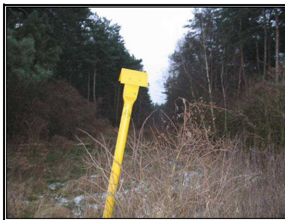
Fot. 3.57 Wycięty pas lasu pod gazociąg wysokiego ciśnienia
