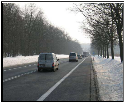
Fot. 3.25 Widok w kierunku węzła „Piotrowo”; po lewej stronie istniejące składowisko odpadów
