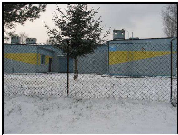
Fot. 3.44 Stacja uzdatniania wody
