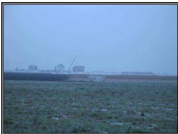
Fot. 3.63 Budowa zachodniej obwodnicy Poznania
