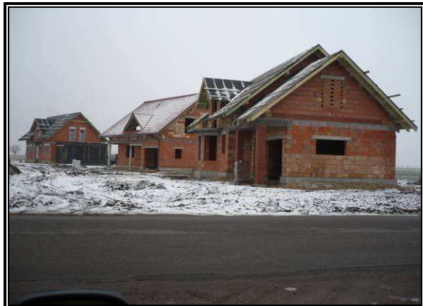
Fot. 3.65 Nowe zabudowania mieszkalne w rejonie węzła „Konarzewo”
