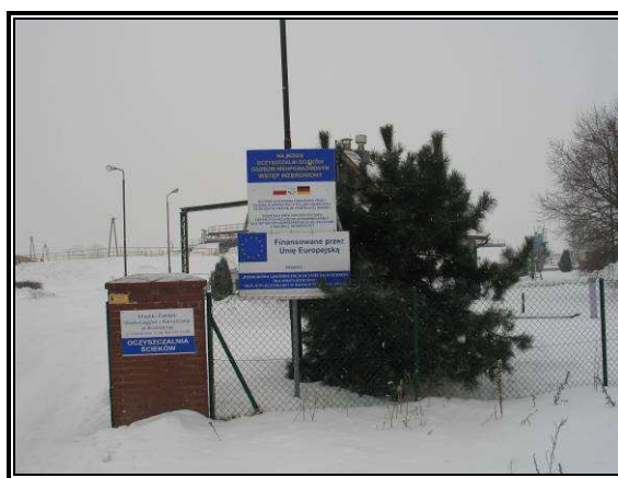
Fot. 3.31 Oczyszczalnia ścieków
