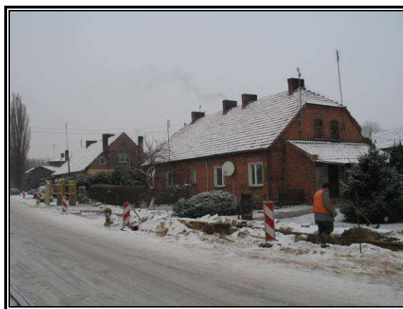
Fot. 3.38 Dom mieszkalny do wyburzenia
