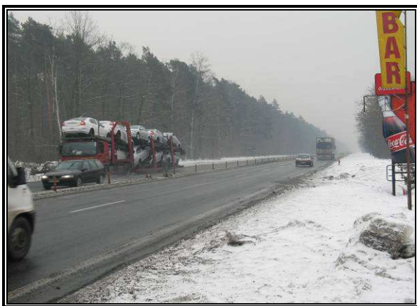
Fot. 3.106 Istniejąca DK 5 za Lesznem (widok w kierunku południowym)
