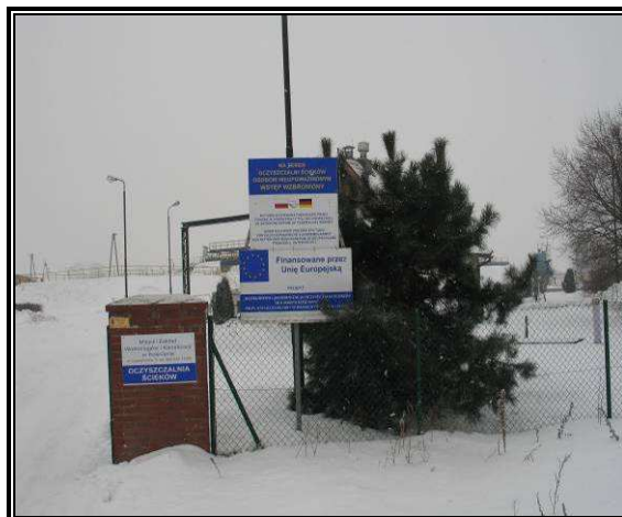
Fot. 3.81 Oczyszczalnia ścieków
