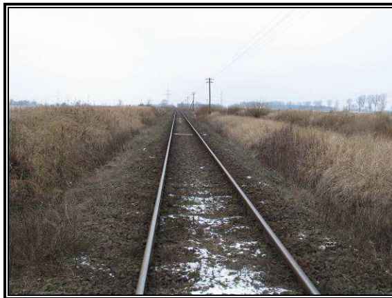
Fot. 3.70 Linia kolejowa nr 357
