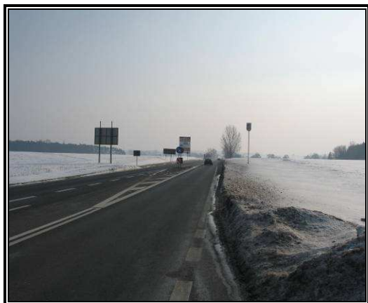
Fot. 3.21 Istniejąca DK 5, widok w kierunku południowym
