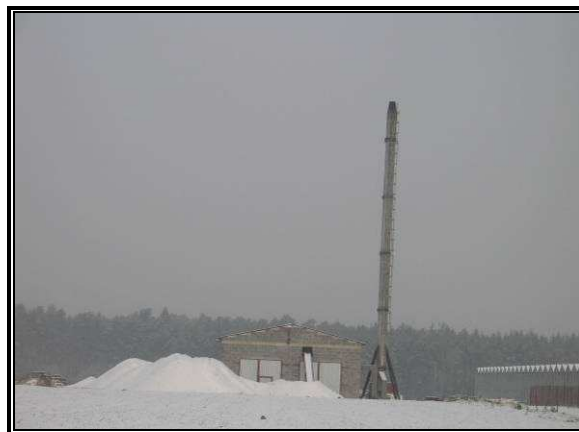
Fot. 3.60 Kotłownia przylegająca do gospodarstwa szklarniowego przewidziana do wyburzenia
