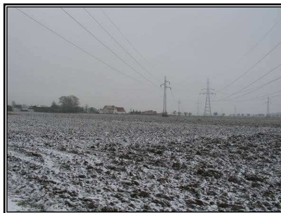
Fot. 3.64 Linia energetyczna 110 kV i 220 kV
