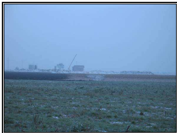
Fot. 3.1 Budowa zachodniej obwodnicy Poznania
