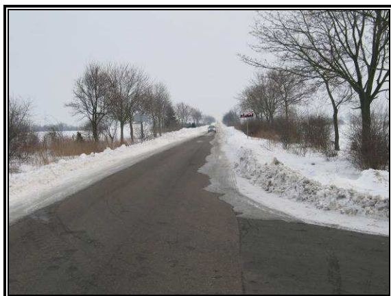
Fot. 3.34 Lokalizacja węzła „Kobylniki”
