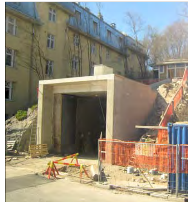
Kuva 4.48. Ajotunnelin suuaukko Turun Kakolanmäen kallio- puhdistamossa.
