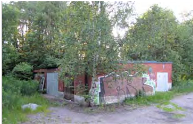
Kuva 4.46. Friisilän nykyinen pumppaamorakennus.
