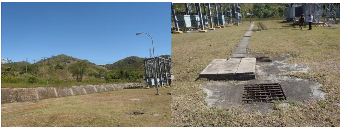
*Foto No. 9 Se observa el drenaje tanto perimetral como interno dentro de la SE Yalaguina, el mismo descrito anteriormente y el cual será construido en la SE Ocotál y Santa Clara. Se puede observar la existencia de vegetación lo cual indica poco escurrimiento por la buena infiltración al subsuelo.*
