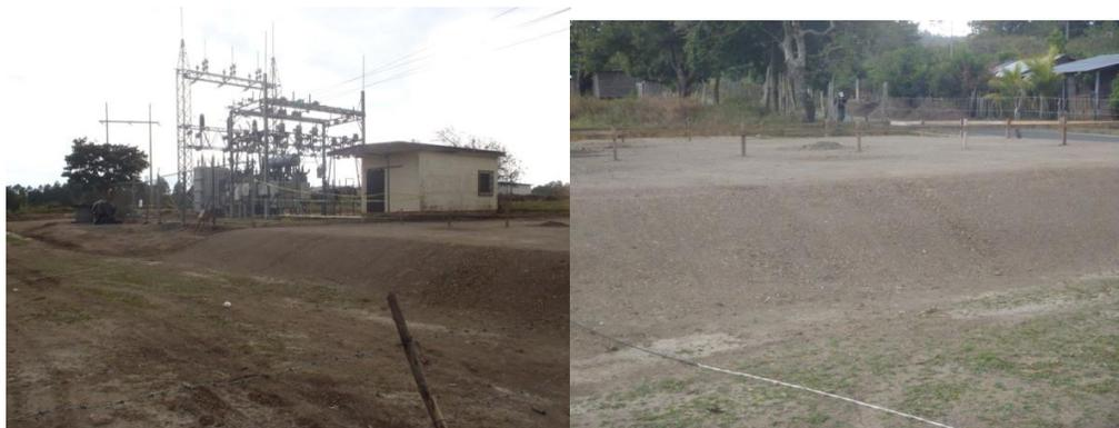
*Foto No. 8 Se observa la cubierta de la superficie de la Subestación Santa Clara conformada con material granular.*
