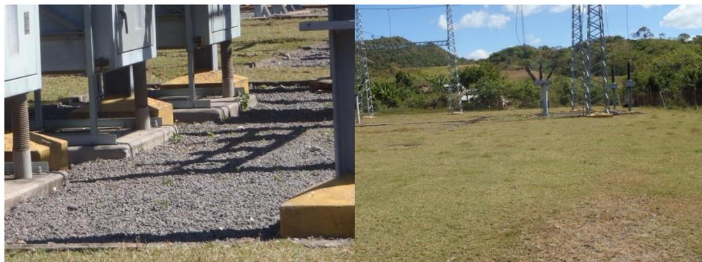
*Foto No. 7 Se observa el piso de la subestación Yalagüina, cubierto de material granular. En la foto de la derecha se observa la superficie cubierta con vegetación gramínea, lo cual propicia el proceso de infiltración de las aguas de escurrimiento.*
