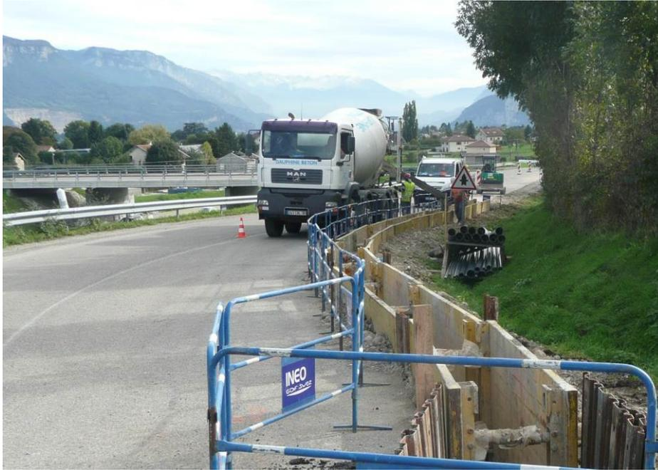
Figure 5 : Génie civil de la tranchée accueillant les fourreaux
