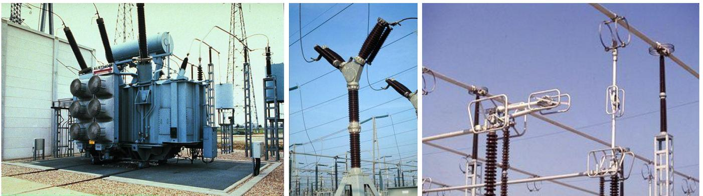
Figure 3 : Vues des éléments constitutifs d'un poste électrique de transformation ; à gauche, transformateur ; au centre, disjoncteur ; à droite, sectionneurs
