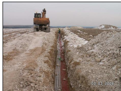
Photo 18 : Pose traditionnelle des câbles électriques
