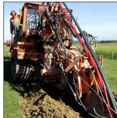
Photo 15 : Pose mécanisée de câbles électriques
