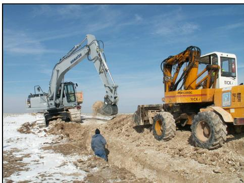
Photo 17 : Tranchée creusée à la pelle mécanique
