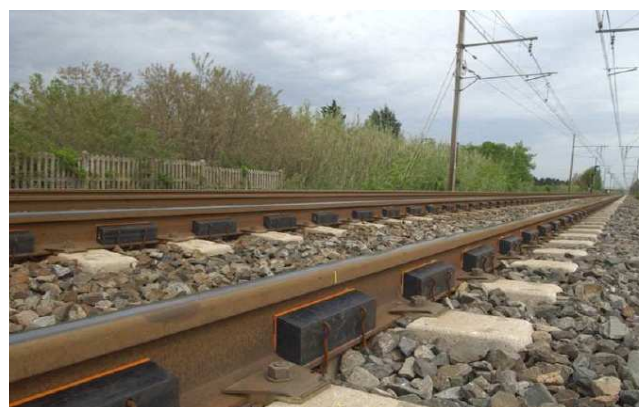
Rys. 52. Przykładowe rozwiązania wkładek przyszynowych.
