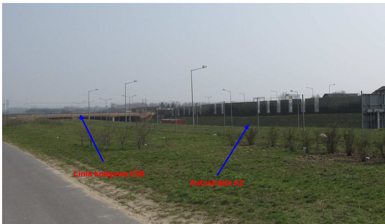
Rys. 46. Widok na skrzyżowanie linii kolejowej E59 z autostradą A2.
