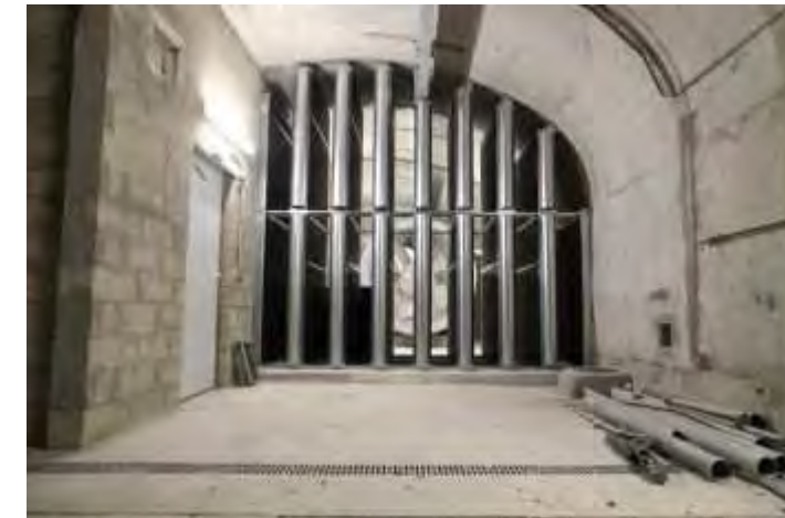
Figure 4.5-1 : Exemple de silencieux intégré dans un rameau de ventilation (source : puits de ventilation ligne métro 4 - http://www.rendezvousavecla4.fr )
