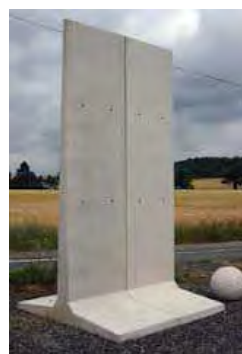
Mur anti-bruits en éléments béton préfabriqués
