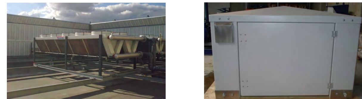
Figure 4.5-3 : Exemples d'écran acoustiques et de capotage ventilé (source : ASM Acoustics)
