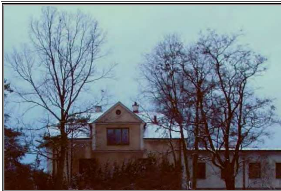
Fot. 12 Budynek przy ul. Marsa 61
