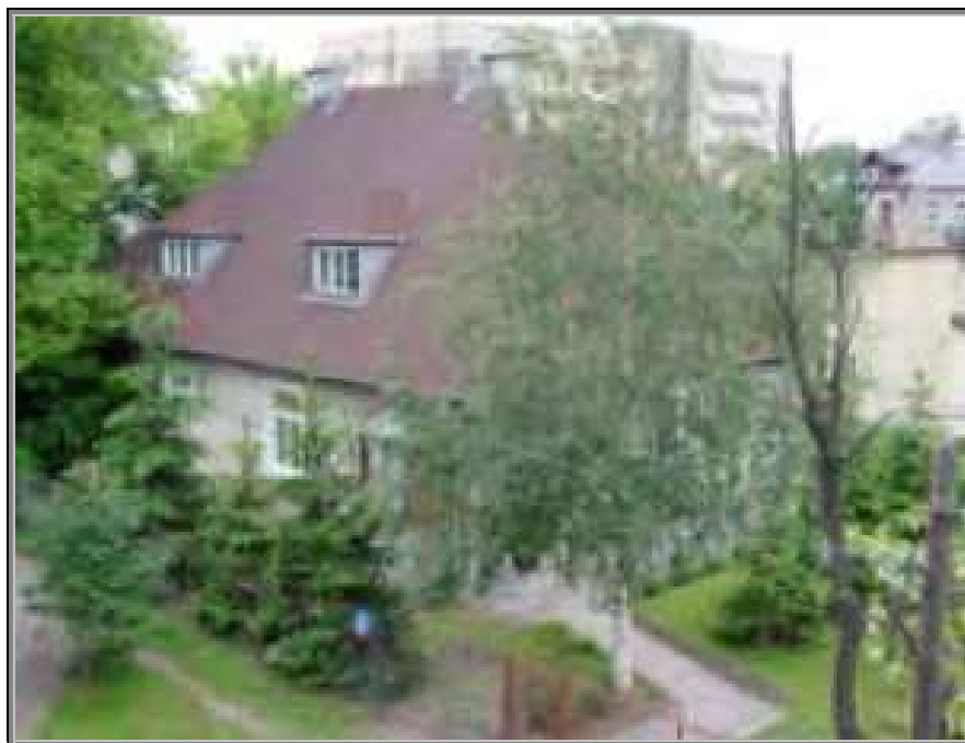
Fot. 11 Budynek przy ul. Marsa 23
