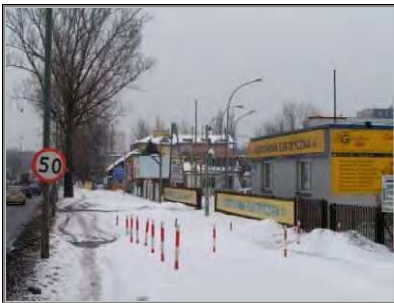
Fot. 3 Przykładowe zagospodarowanie terenów przy ul. Marsa
