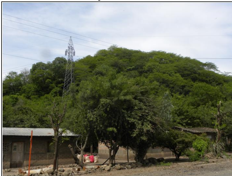
Figura 5.7 Camino Puertas Viejas – Las Pencas Esquipulas (Estaba terminando de adoquinarse al momento de la visita de sitio) Municipio Ciudad Darío
