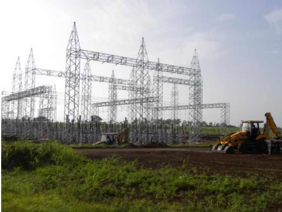
Figura 4.16.Subestación San Benito en proceso de construcción
