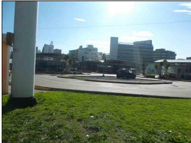
Fotografía N° 1.- Interior del predio donde se construirá el edificio de la PGEP
