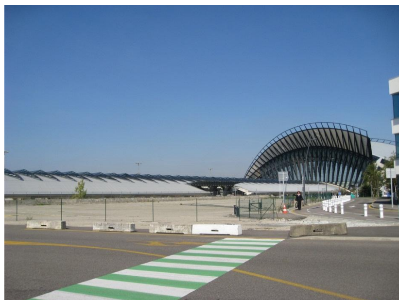
Circulation piétonne entre la gare TGV et le terminal 3 (Egis France)
