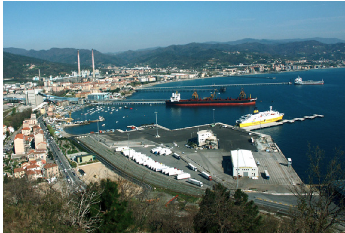
FIGURA 2-2 – LA RADA DI VADO LIGURE. SONO VISIBILI, NELLA PARTE SUPERIORE, IL TERMINAL TRAGHETTI (CORSICA FERRIES-SARDINIA FERRIES), IL PONTILE DELLA TERMINAL RINFUSE (PONTILE SAN RAFFAELE), IL PONTILE DELLA ESSO ITALIANA ED IL PONTILE DELLA PETROLIG; NELLA PARTE INFERIORE È VISIBILE IL TERMINAL REEFER CON L'AREA DEI MAGAZZINI ED IL BACINO DI EVOLUZIONE DELIMITATO DALLA DIGA FORANEA.
