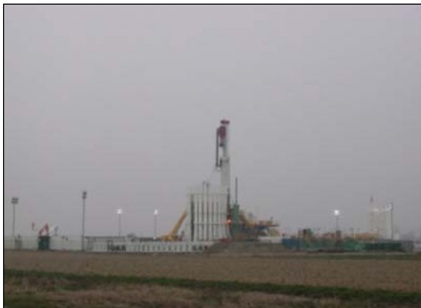
Figura 4.2.2.a – Vista dell'impianto di perforazione HH220
