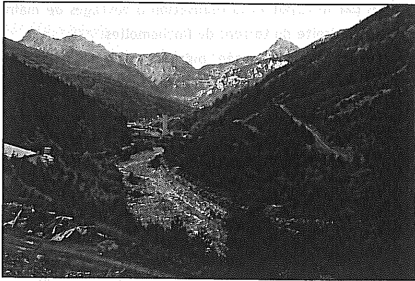
ENTREE DU TUNNEL - Zone de dépôt
