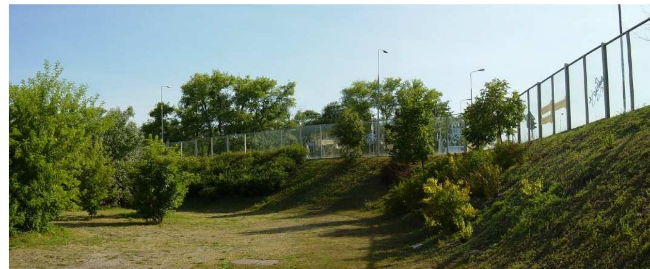
Fot. 10 Przykład ekranu przezroczystego wysokości 4m na nasypie wysokości ok. 6m
