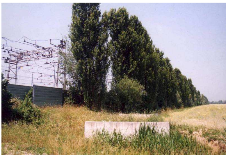
Foto 1: Fascia boscata tampone, a circa 18 anni dall'intervento in Loc Muscoli, scalo ferroviario di Cervignano (UD), Foto G. Sauli – 2003
