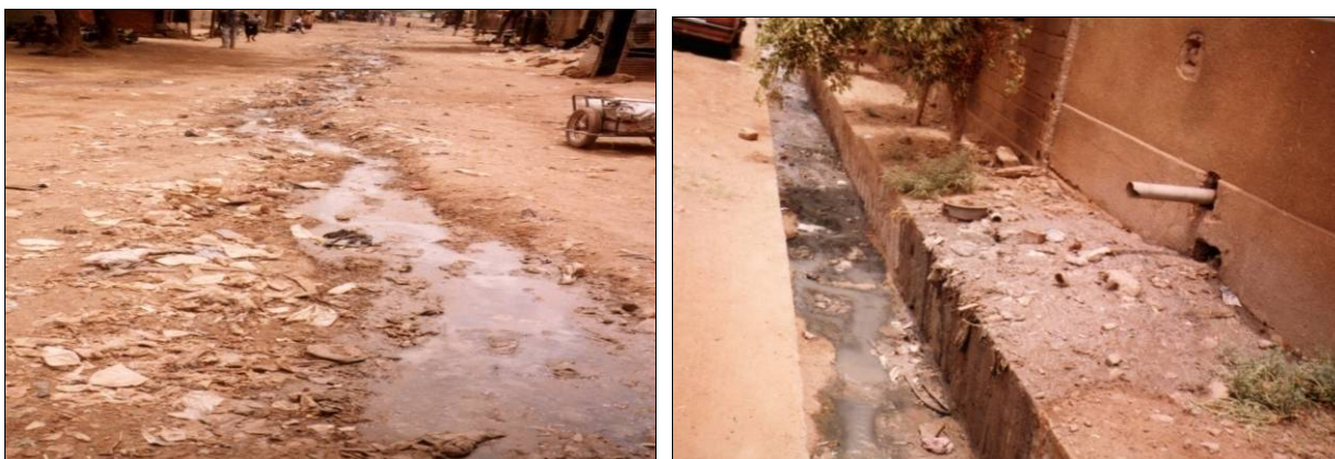
Photo 11 : réseaux de drainage des eaux pluviales de Bamako
