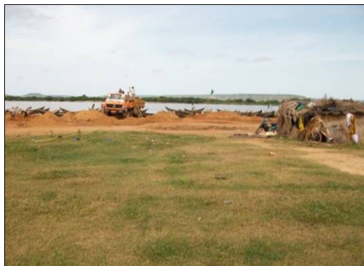
Photo 1 : site de la station d'exhaure et de l'ouvrage de prise
