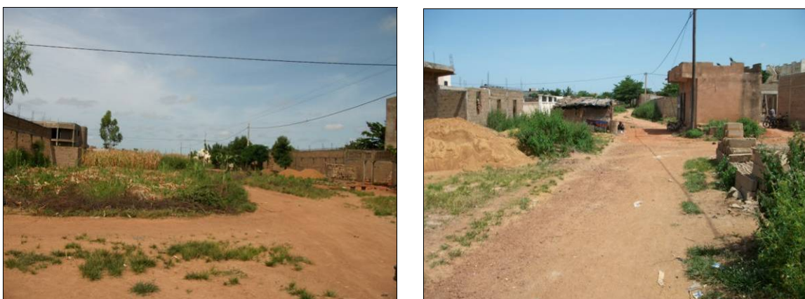
Photo 4 : emprise de la conduite d'adduction au niveau de Tiébani et de Kalabankoro
