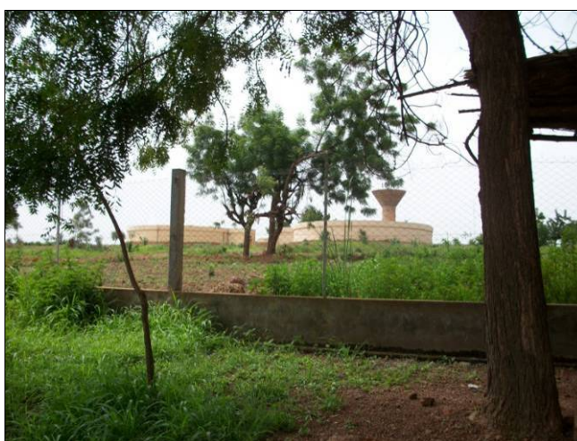
Photo 7 : Site des réservoirs de Badalabougou
