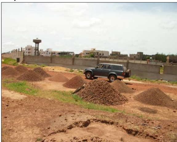
Photo 6: Site des réservoirs de Bacodjicoroni
