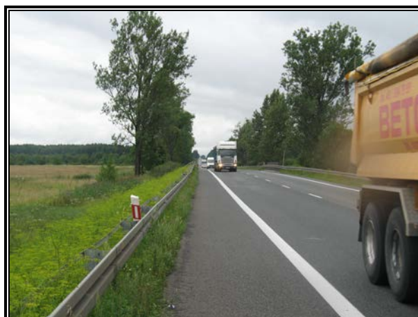
Fot. 3.2 Istniejąca DK7, rejon Oleśnicy, widok w kierunku północnym
