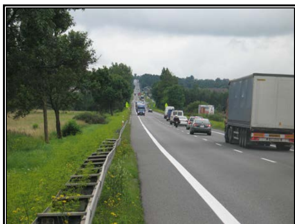
Fot. 3.1 Istniejąca DK7, rejon Oleśnicy, widok w kierunku południowym
