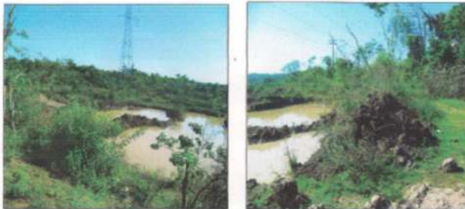
Figura 7.3 - Minas profundas de arcilla cerca de una torre.
