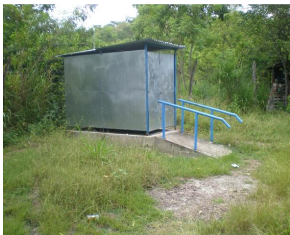
Figura 1.4: Letrina ubicada en centro “Los Pipitos”
