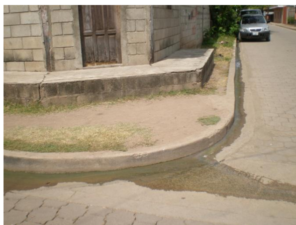
Figura 1.7: Charcas de aguas residuales en calles de Condega
