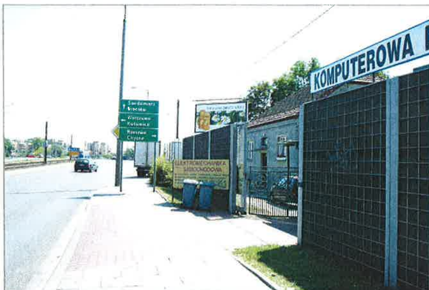
Fot. 7. Ekran akustyczny przy al. Jana Pawła II w pobliżu zjazdu do ul. Nowohuckiej, (widok w kierunku wschodnim, lipiec 2008)
