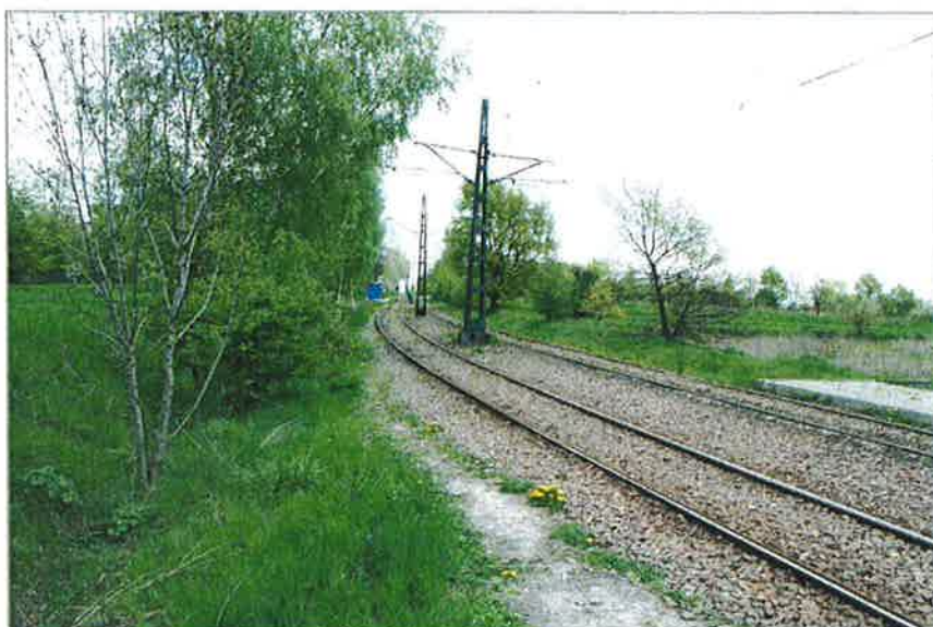
Fot. 14. Podjazd do pętli Wzgórze Krzesławickie; po lewej rejon równoległej do toru ul. Kocmyrzowskiej, po prawej – rezerwa terenu dla rozbudowy Cmentarza Grębałowskiego (widok w kierunku północno-wschodnim, kwiecień 2008)
