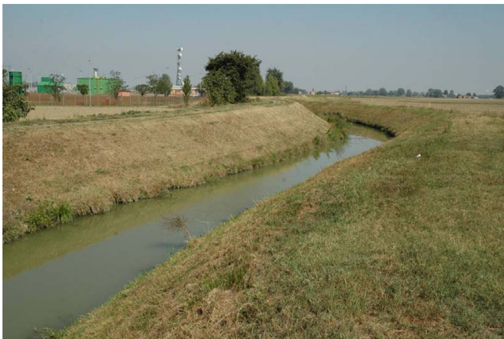
Foto 4.3 - Scolo Zena nei pressi della centrale di Minerbio.
