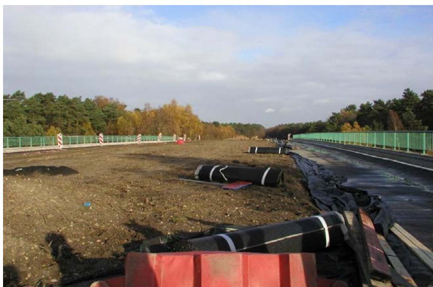
Przejście nad drogą – w fazie budowy
