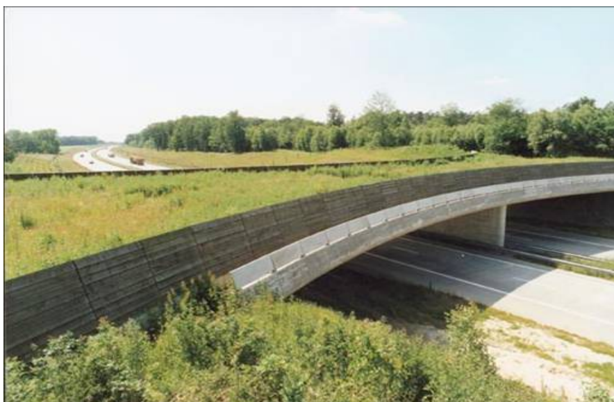
Przejście nad drogą – po zakończeniu budowy
