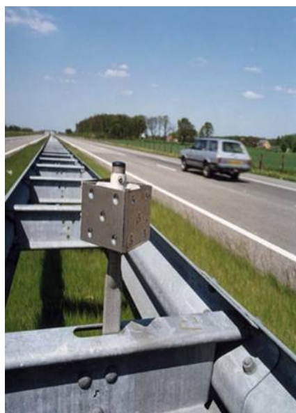
Elementy odblaskowe odstrasżające zwierzęta przed wtargnięciem na jezdnię
