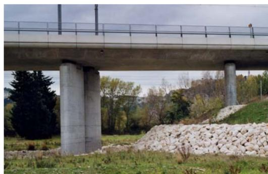
Ouvrage de décharge assurant la transparence hydraulique
