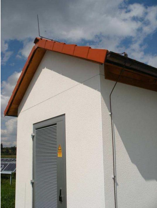
Dans le cadre d'un projet de ferme photovoltaïque, il est envisagé d'installer un ou des onduleurs centraux logés dans des cabanons d'une vingtaine de mètres carrés et d'une hauteur d'environ 3 mètres abritant également un transformateur moyenne tension.
